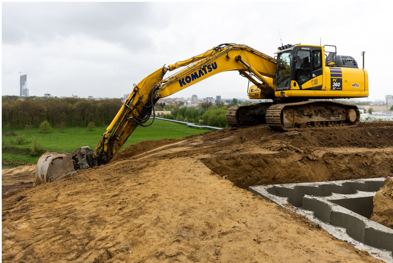
zdjęcie z terenu budowy, fot. Grzegorz Bukala, Urząd Miasta Rzeszowa
