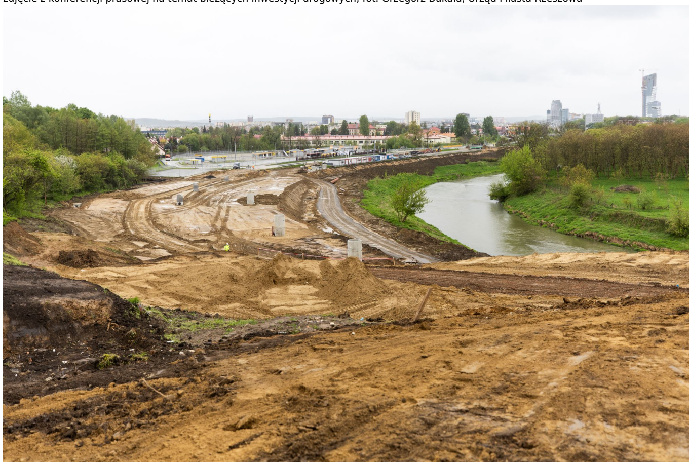
zdjęcie z terenu budowy, fot. Grzegorz Bukała, Urząd Miasta Rzeszowa
