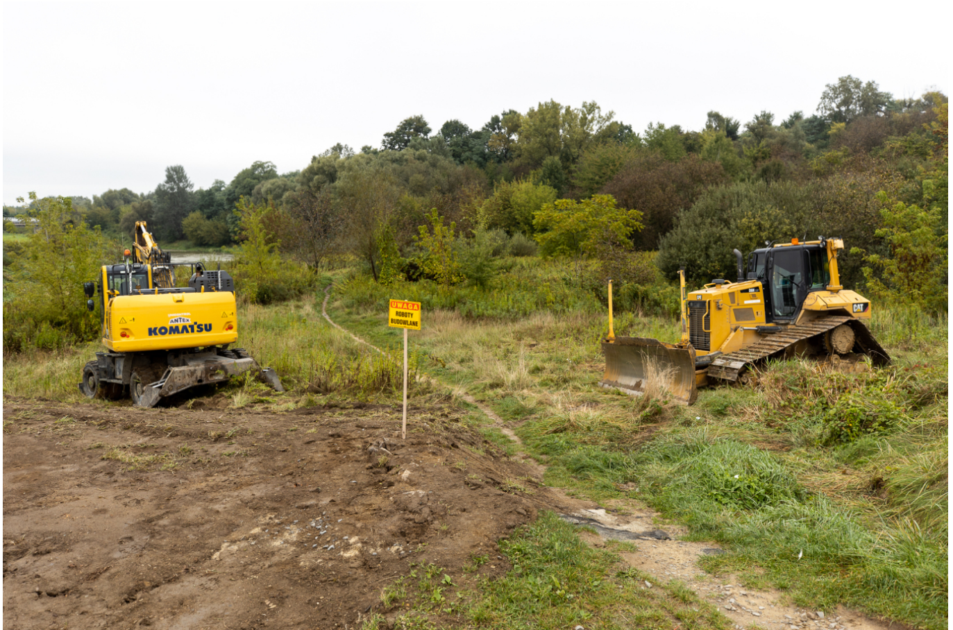
Rozpoczęcie budowy Wisłokostrady, fot. Grzegorz Bukala / Urząd Miasta Rzeszowa
