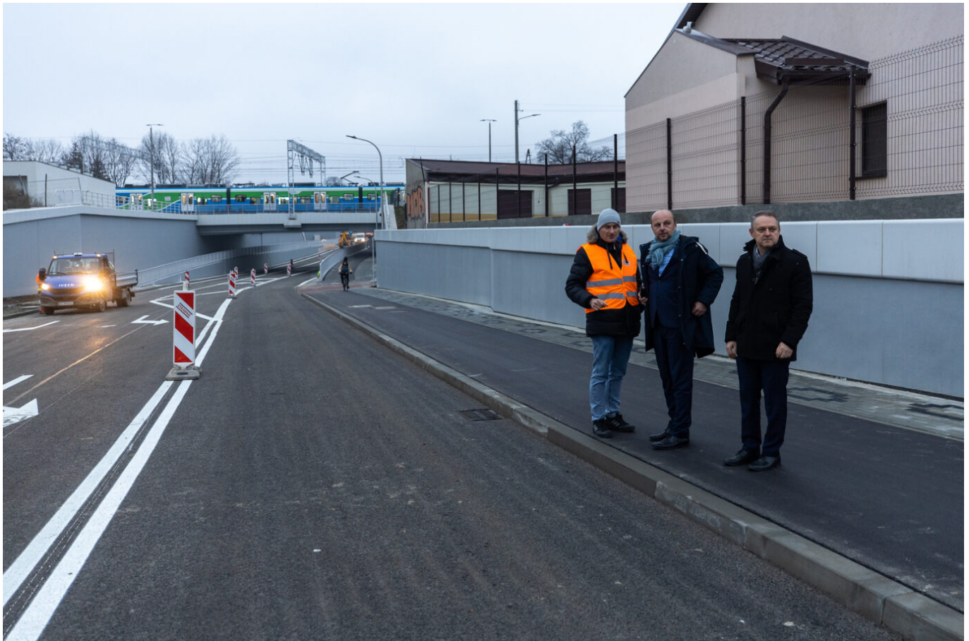
Przejazd pod wiaduktem na ul. Batorego, fot. Grzegorz Bukała / Urząd Miasta Rzeszowa
