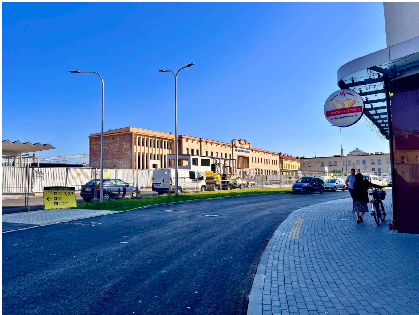
Przebudowa układu drogowego w rejonie głównego dworca kolejowego
