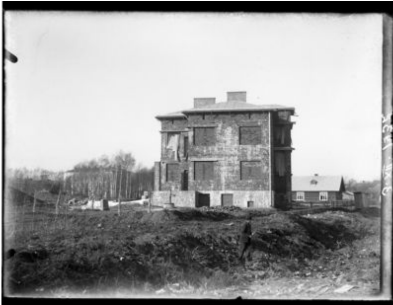
Zdjęcie z budowy willi Fryderyka Janusza, obecnie siedziby Estrady Rzeszowskiej przy ul. Jagiellońskiej 24, wykonane 3 grudnia 1932 roku. Fotografia przedstawia budynek jeszcze w stanie surowym. W tle widoczny drewniany dom, który obrazuje, w jak tradycyjnej i skromnej zabudowie przedmieścia miały miejsce pierwsze próby unowocześniania pejzażu architektonicznego miasta. Zdjęcie ze zbiorów Galerii Fotografii Miasta Rzeszowa
