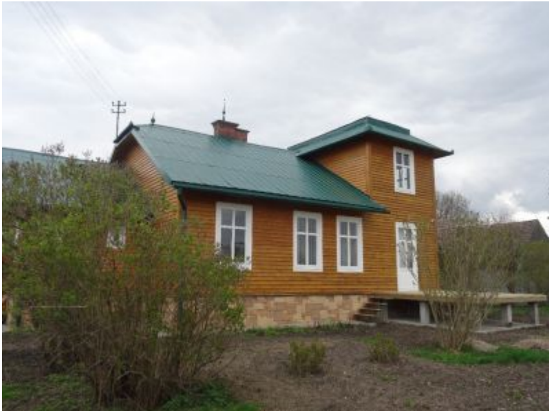
Zabytkowy dom właściciela młyna przy ul. Łąkowej 6, widok od północnego zachodu. Materiały Biura Miejskiego Konserwatora Zabytków UM Rzeszowa
