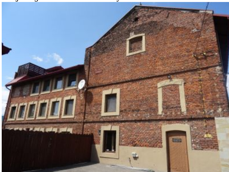
Skrzydło "dużego" młyna handlowego z 1938 roku, południowo-zachodnia ściana szczytowa. Po lewej skrzydło młyna od ul. Łąkowej. Materiały Biura Miejskiego Konserwatora Zabytków UM Rzeszowa
