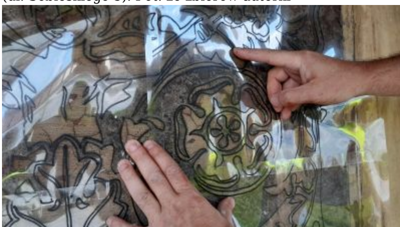
Odręczne zdejmowanie rysunku z zachowanych fragmentów sgraffita. Astralon przykładano do zniszczonej sceny i markerem rysowano zachowane elementy kompozycji (ul. Sobieskiego 5). Fot. ze zbiorów autorki
