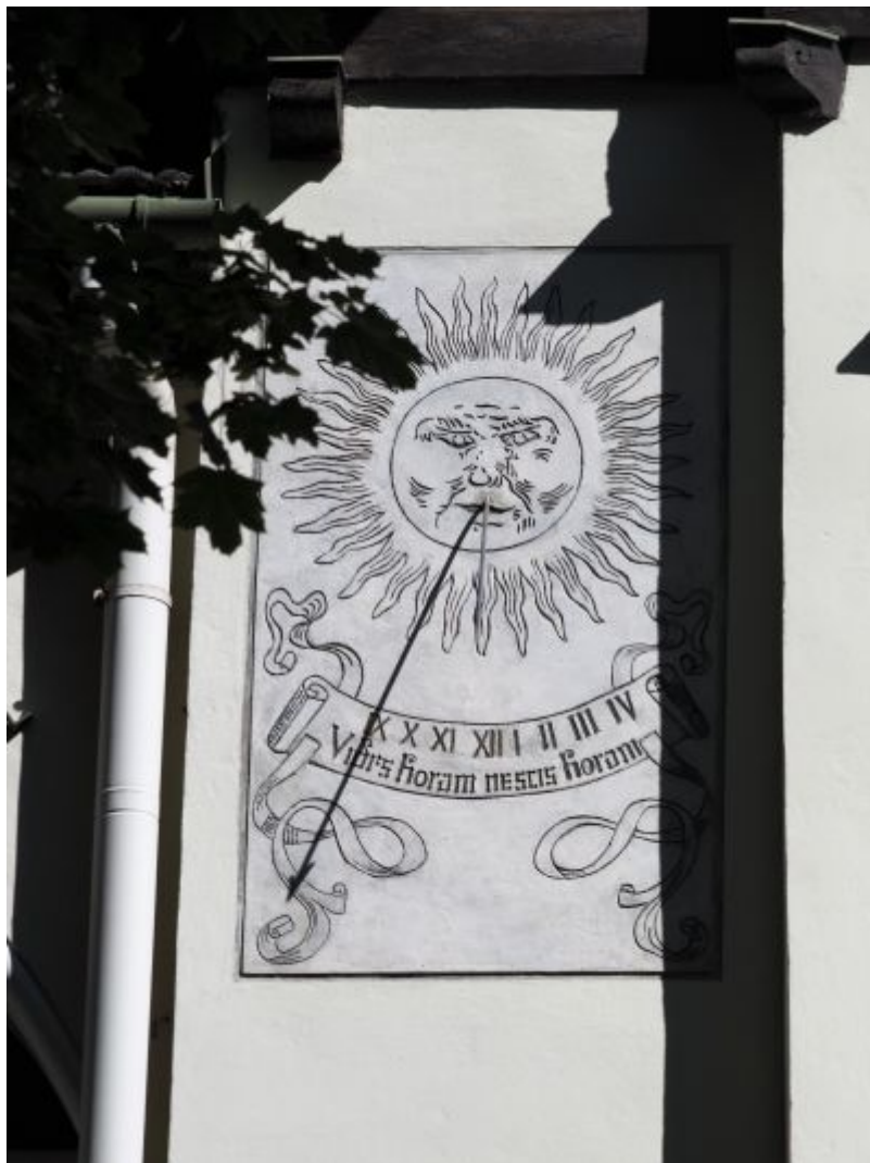
Monochromatyczne sgraffito z willi Tadeusza Tekielskiego z Alei Pod Kasztanami 10. Spodnia warstwa zaprawy zabarwiona została węglem drzewnym, na którą naniesiona została warstwa pobiły wapiennej. Fot. Ludmiła Łapka
