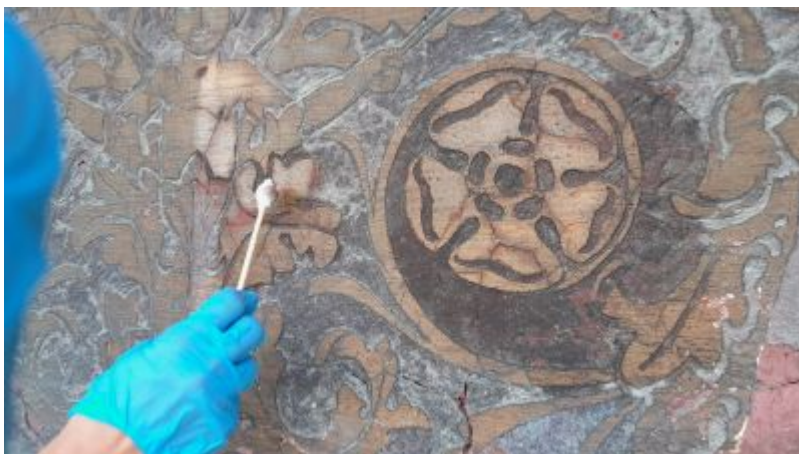
Próby chemicznego usuwania szernień z powierzchni sgraffita (ul. Sobieskiego 5). Fot. ze zbiorów autorki
