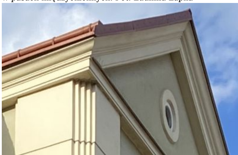
Zbliżenie na ryzalit klatki schodowej elewacji południowej od ul. Sobieskiego. Widoczne rozrzeźbione pilastry narożne, gzyms i obramienie tympanonu. Fot. Ludmiła Łapka
