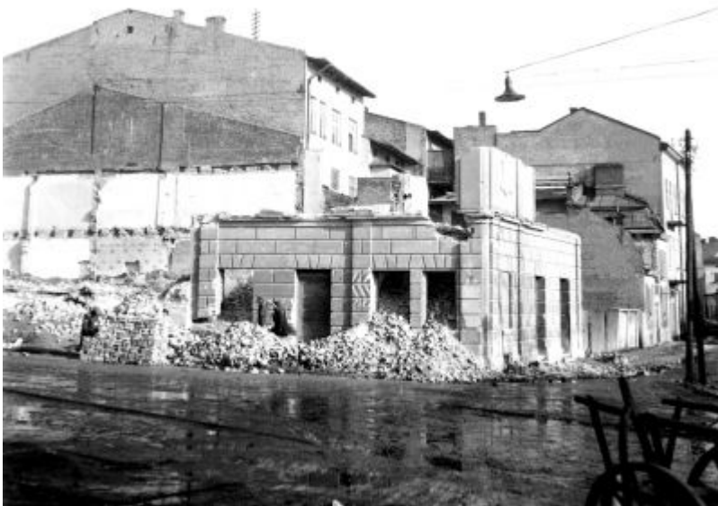
Rok 1941: na skutek zawalenia piwnic dokonano rozbiórki kamienic w pierzei południowej Rynku. Widok od strony ul. Króla Kazimierza (dzisiejszy parking pod Ratuszem). Fotografia z czasów okupacji ze zbiorów Galerii Fotografii Miasta Rzeszowa
