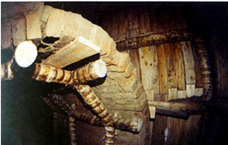
Lata 80. XX w.: zdjęcia ilustrujące akcję ratunkową zabezpieczania podziemnych wyrobisk pod płytą Rynku. Fotografie ze zbiorów Biura Miejskiego Konserwatora Zabytków UM Rzeszowa
