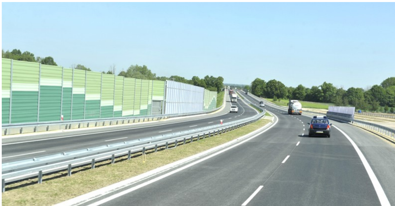
Łącznik do autostrady A4, fot. Bogdan Szczupaj
