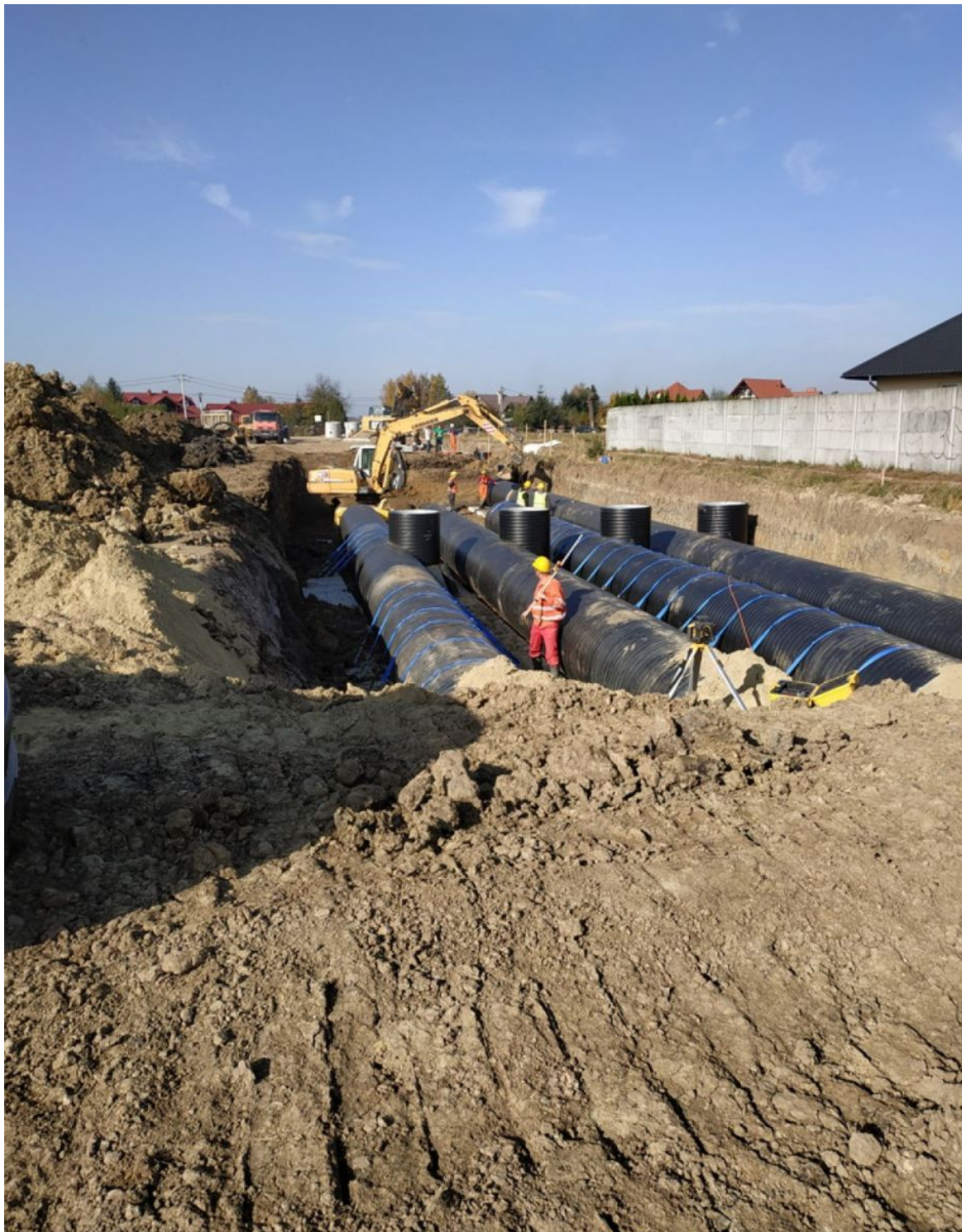
Budowa kanalizacji na Budziwoju
