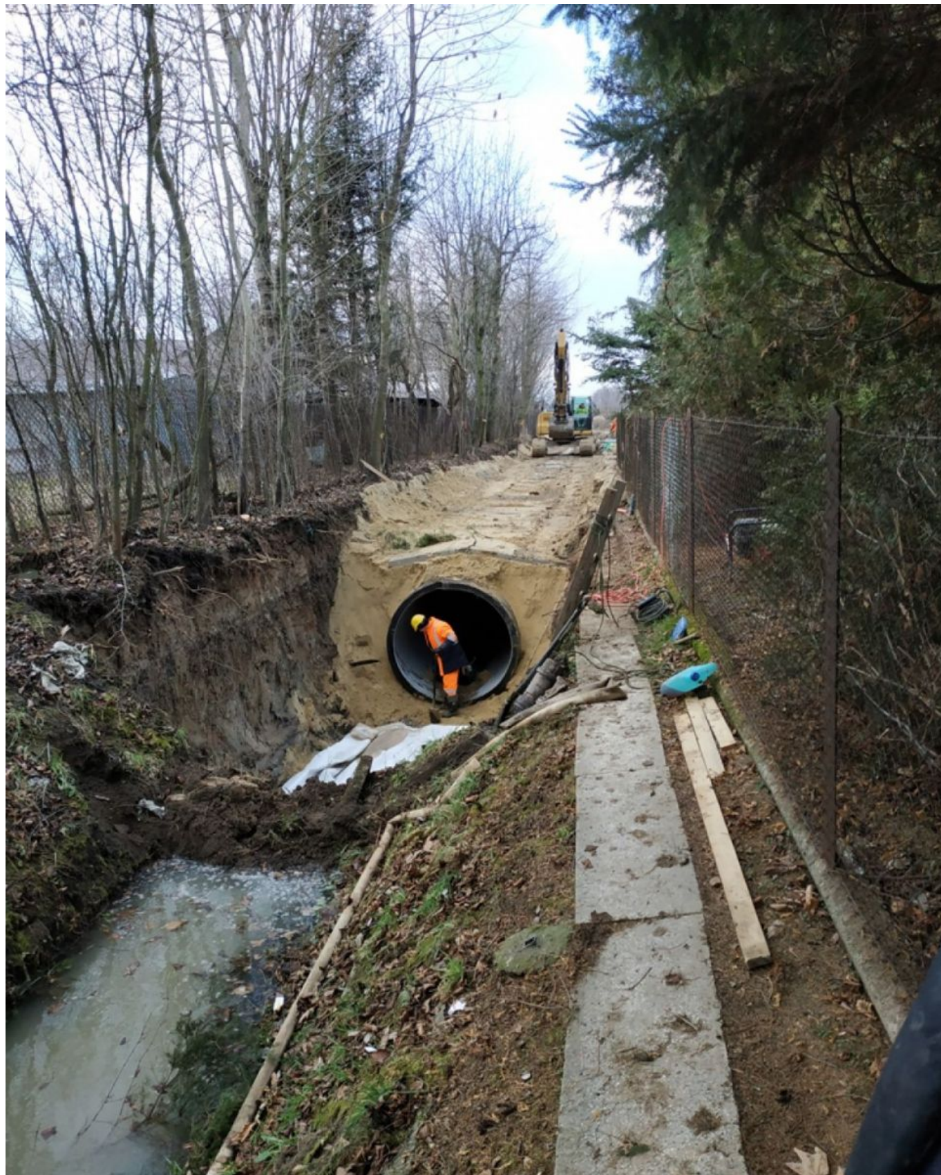
Budowa kanalizacji na Budziwoju
