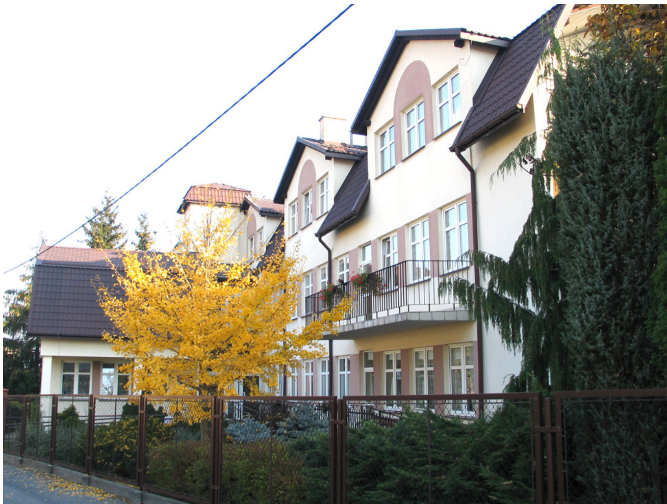
DPS przy ul. Łabędziej
