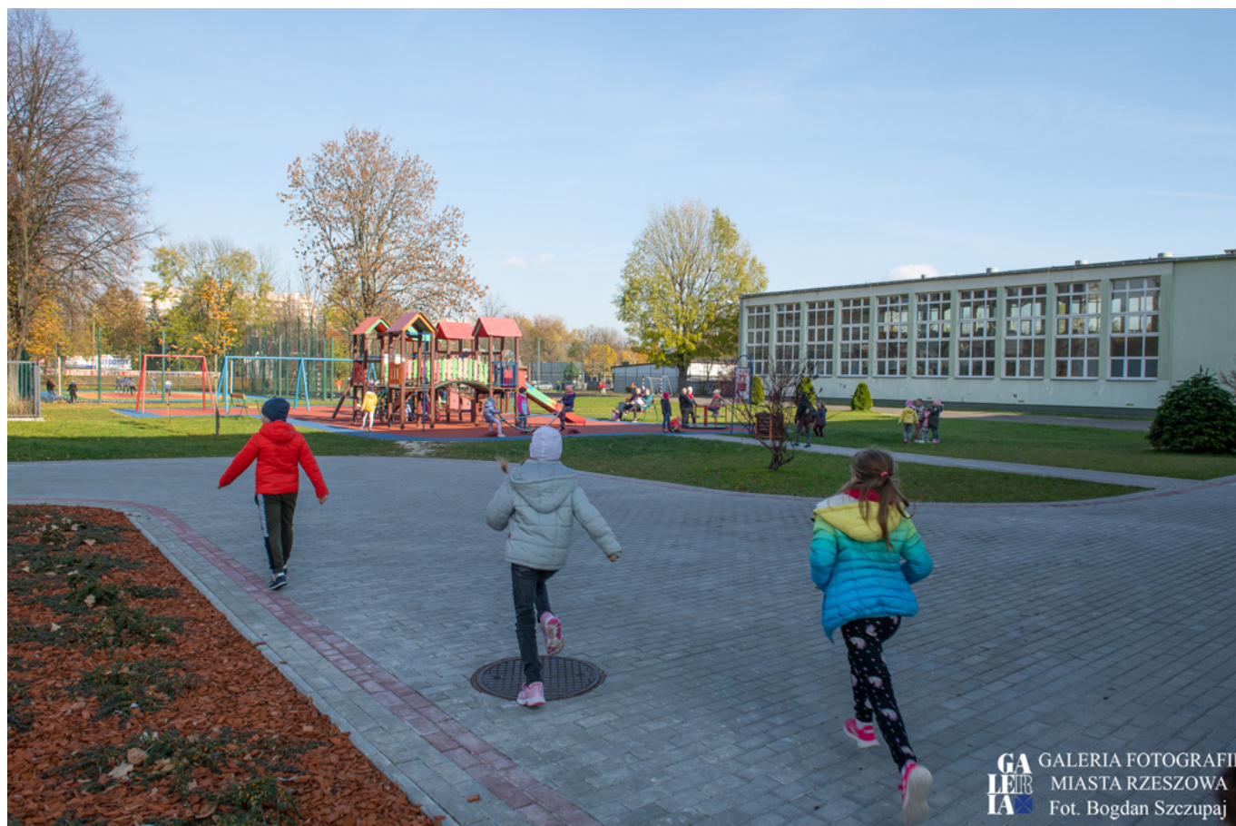
Budowa bieżni lekkoatletycznej wraz z wymianą nawierzchni wokół placu zabaw na terenie ogólnodostępnym przy Szkole Podstawowej nr 16
