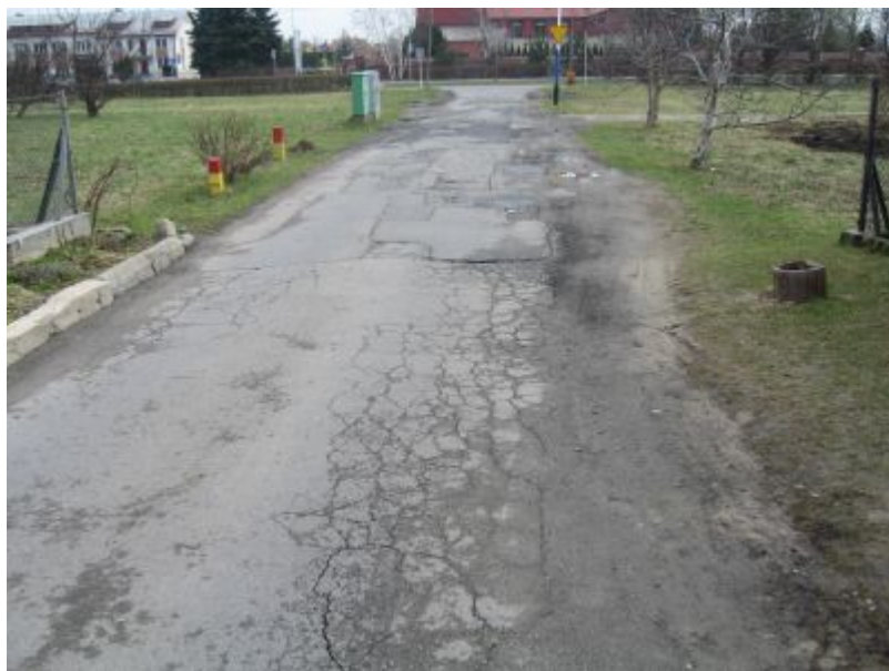
Fragment ul. Morgowej przeznaczony do przebudowy
