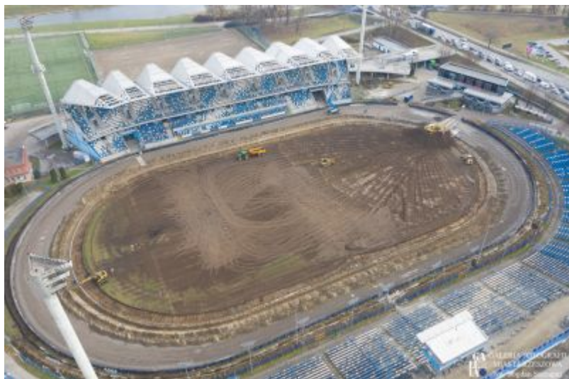
Stadion Miejski w trakcie przebudowy
