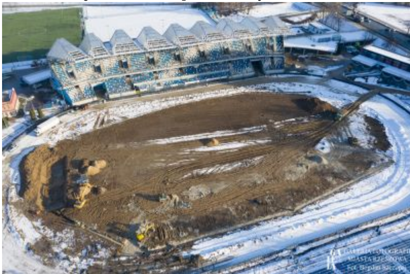
Stadion Miejski w trakcie przebudowy
