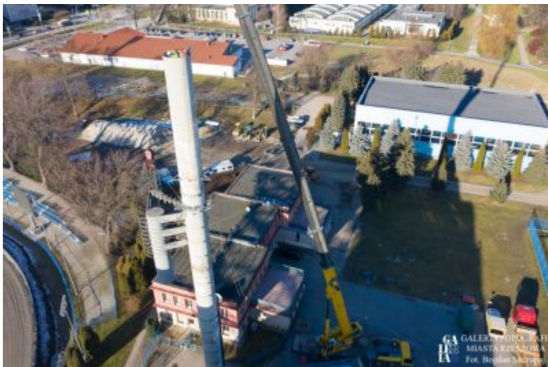
Stadion Miejski w trakcie przebudowy
