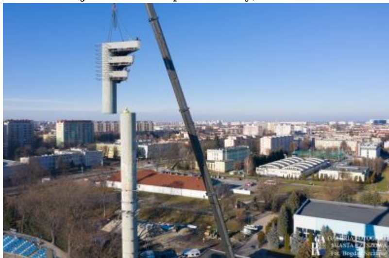
Stadion Miejski w trakcie przebudowy
