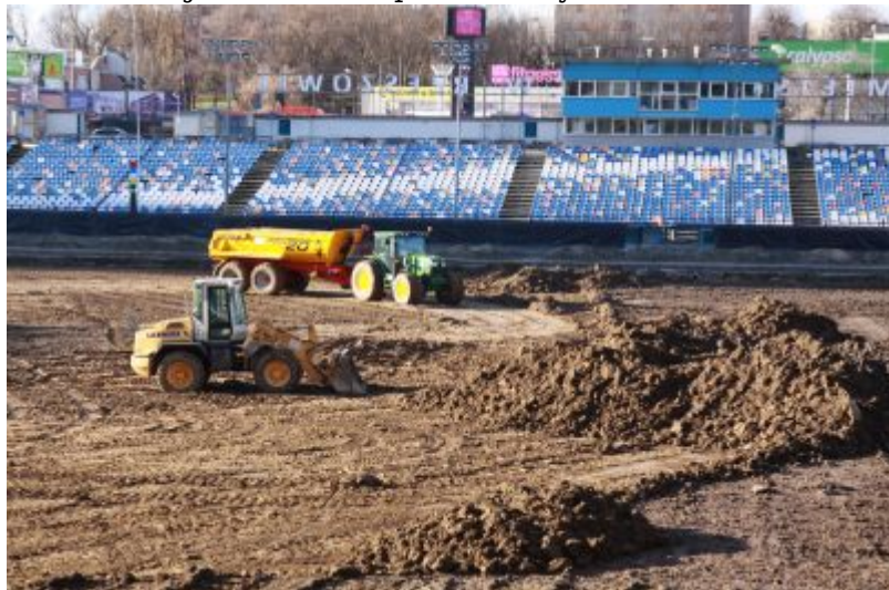
Stadion Miejski w trakcie przebudowy, fot. A. Baranowski
