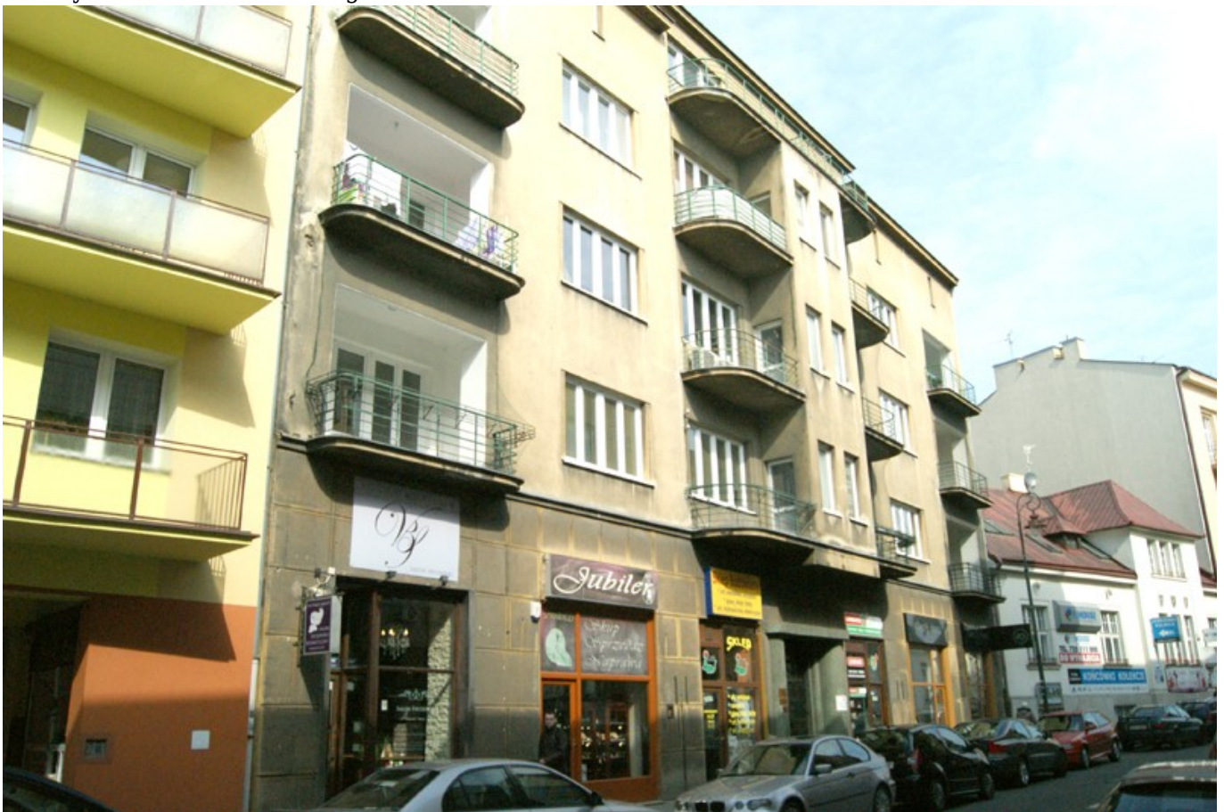
Kamienica wg proj. Karola Holzera przy ul. Jagiellońskiej
