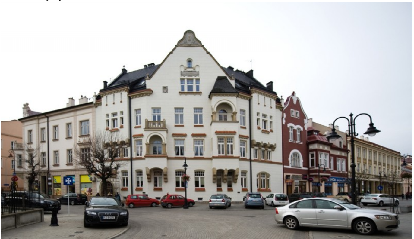
Kamienica architekta Tadeusza M. Tekielskiego wybudowana w 1910 r. przy ob. ul. 3 Maja
