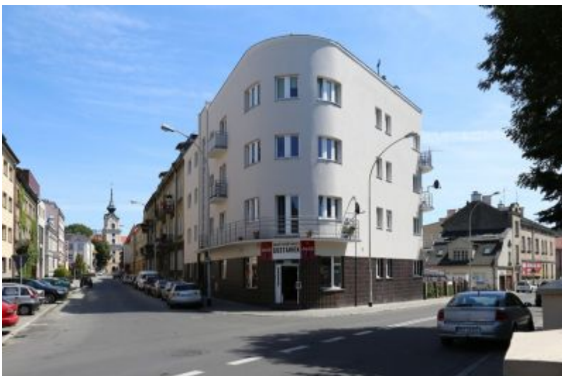
Dom-statek przy ul. Kraszewskiego 7 z końca lat 30. Obecny wygląd budynku zawdzięcza się trafnemu przywróceniu jego pierwotnej, jasnej kolorystyki, wpisującej się w genius loci architektury modernistycznej.
