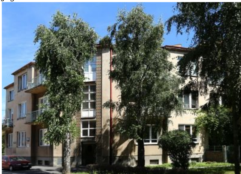
Dom-rzeźba przy ul. Lenartowicza 25 o uskokowo ukształtowanej elewacji frontальной oraz pięknej oprawie z barwnej terakoty okien klatki schodowej. Koniec lat 30.
