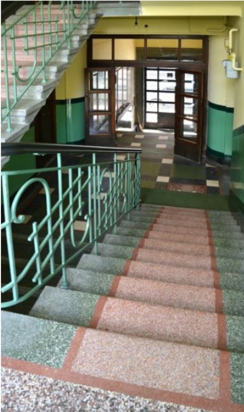
Klatka schodowa kamienicy przy ul. Jagiellońskiej 12 wyłożona barwionym, szlifowanym lastrikiem. We wnętrzu zachowała się również metalowa balustrada oraz stolarka drewniana ze szkłem kryształowym.
