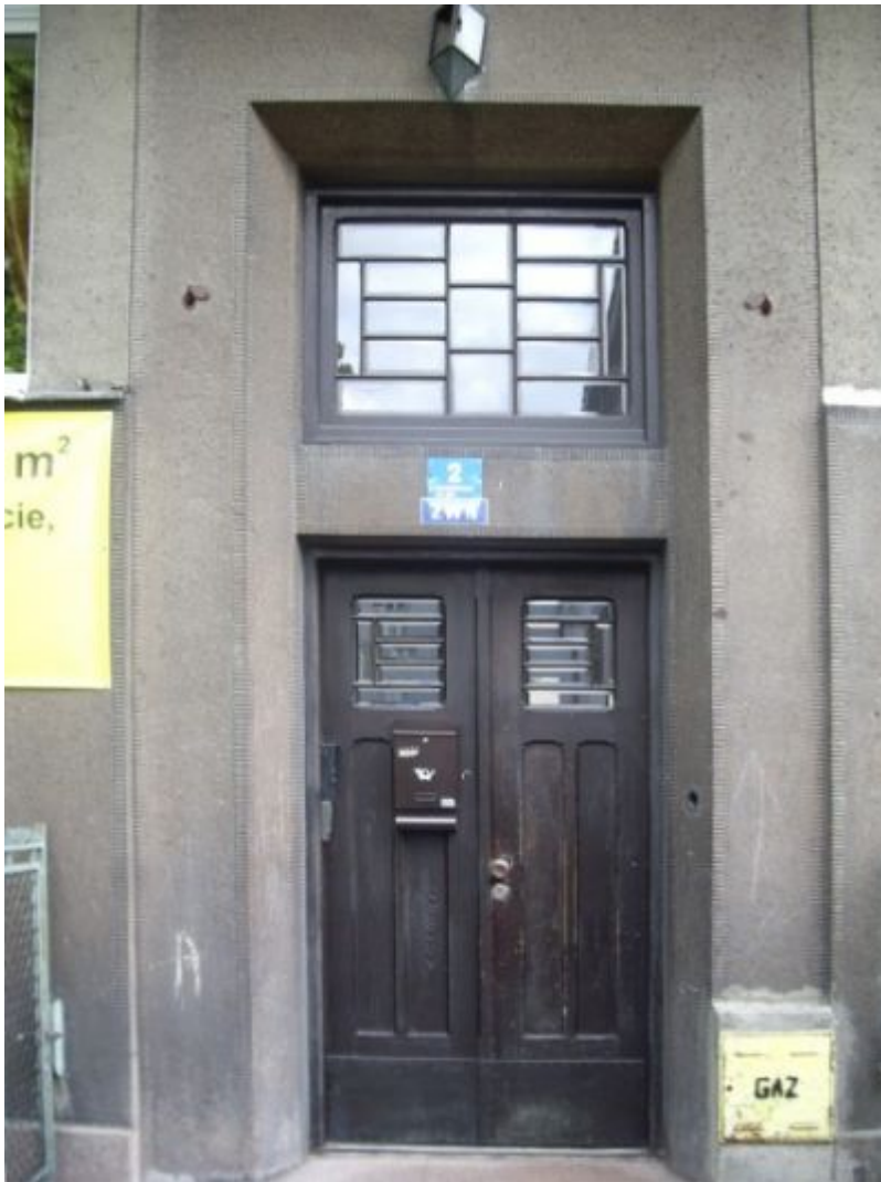
Ozdobny portal kamienicy przy ul. Alsa 2, J. Czadek, 1937.
