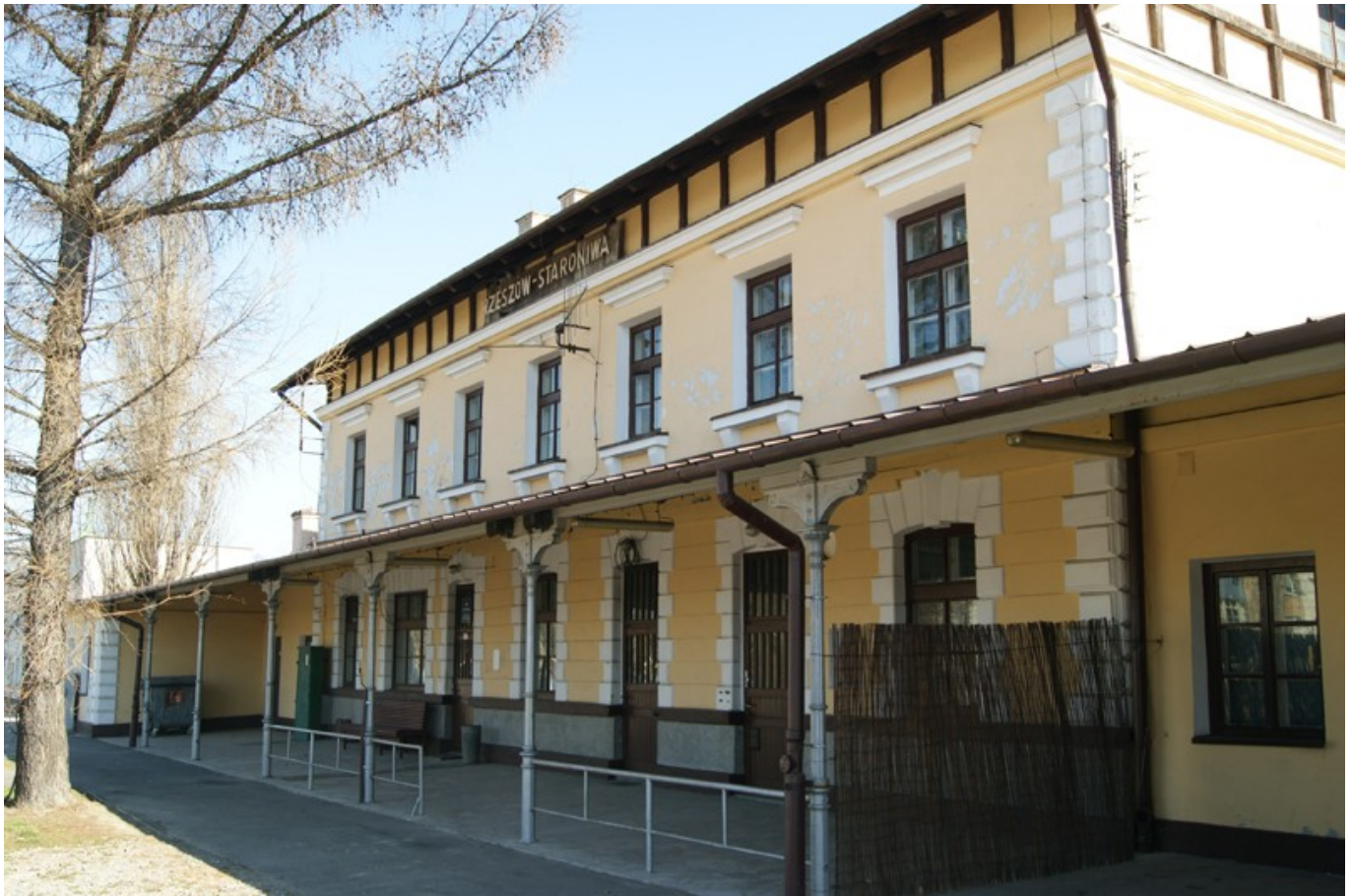
Stacja Rzeszów - Staroniwa
