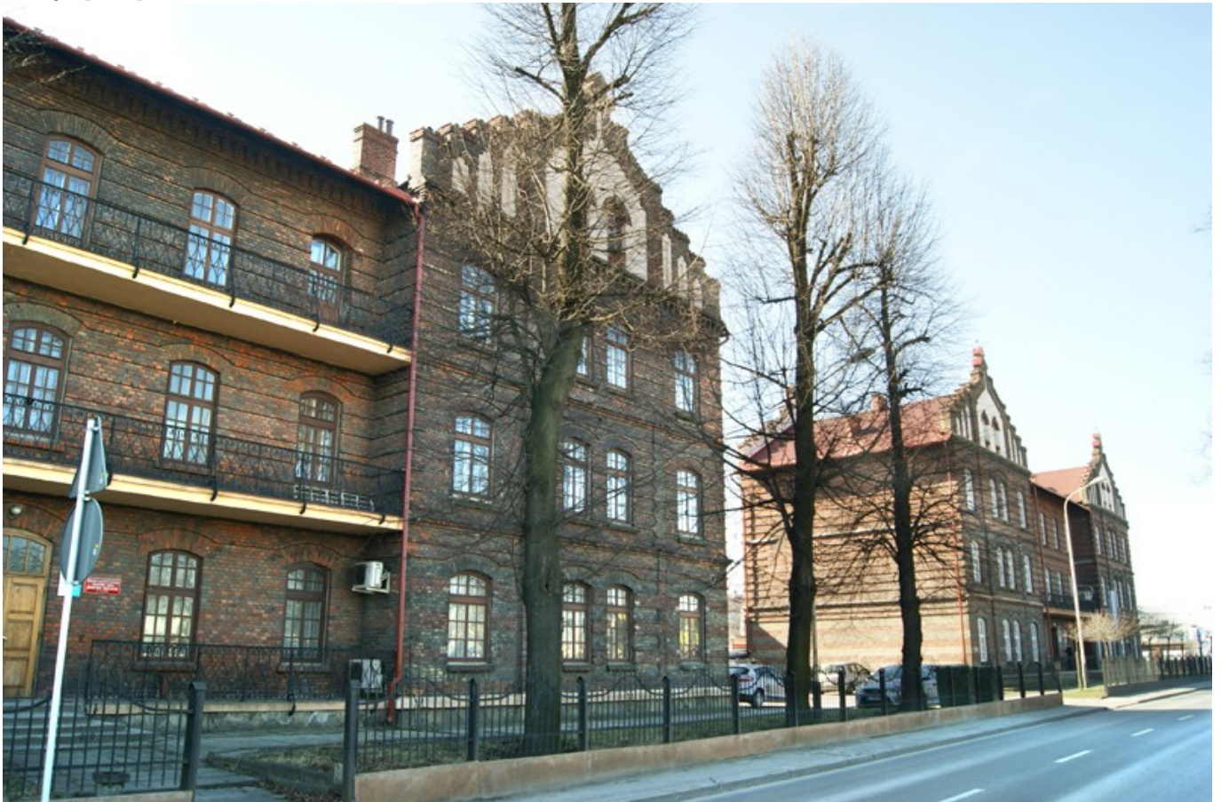
Budynek Dyrekcji Kolei
