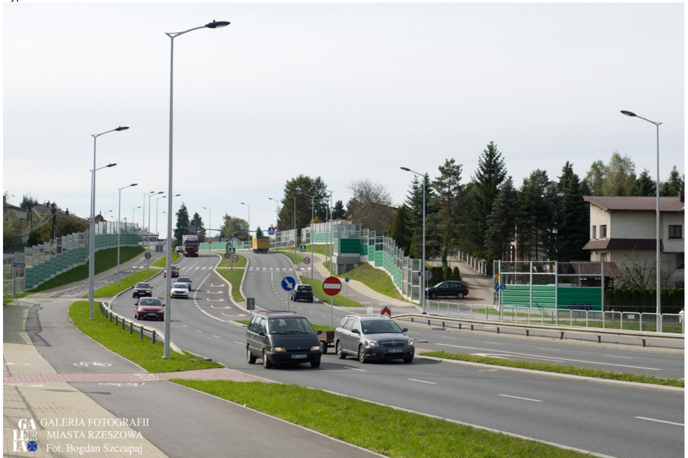
Zmodernizowana ulica Podkarpacka
