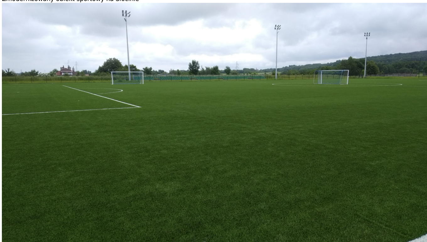
Zmodernizowany obiekt sportowy na Słocinie
