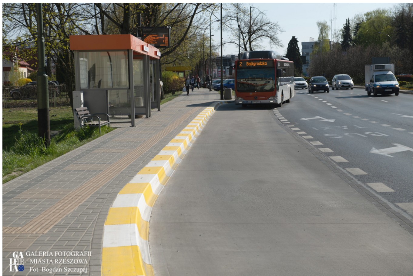
Przebudowana zatoka autobusowa przy ul. Lisa-Kuli
