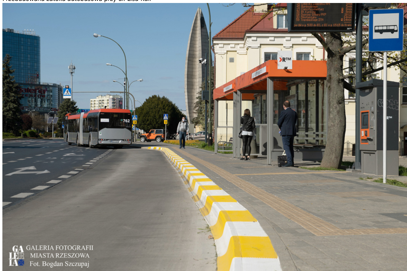
Przebudowana zatoka autobusowa przy ul. Lisa-Kuli
