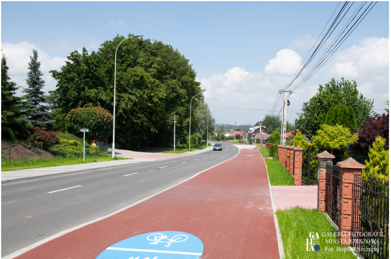
Rozbudowana ul. Jana Pawła II
