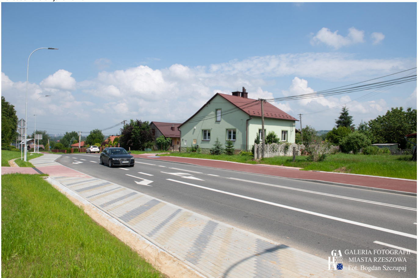
Rozbudowana ul. Jana Pawła II
