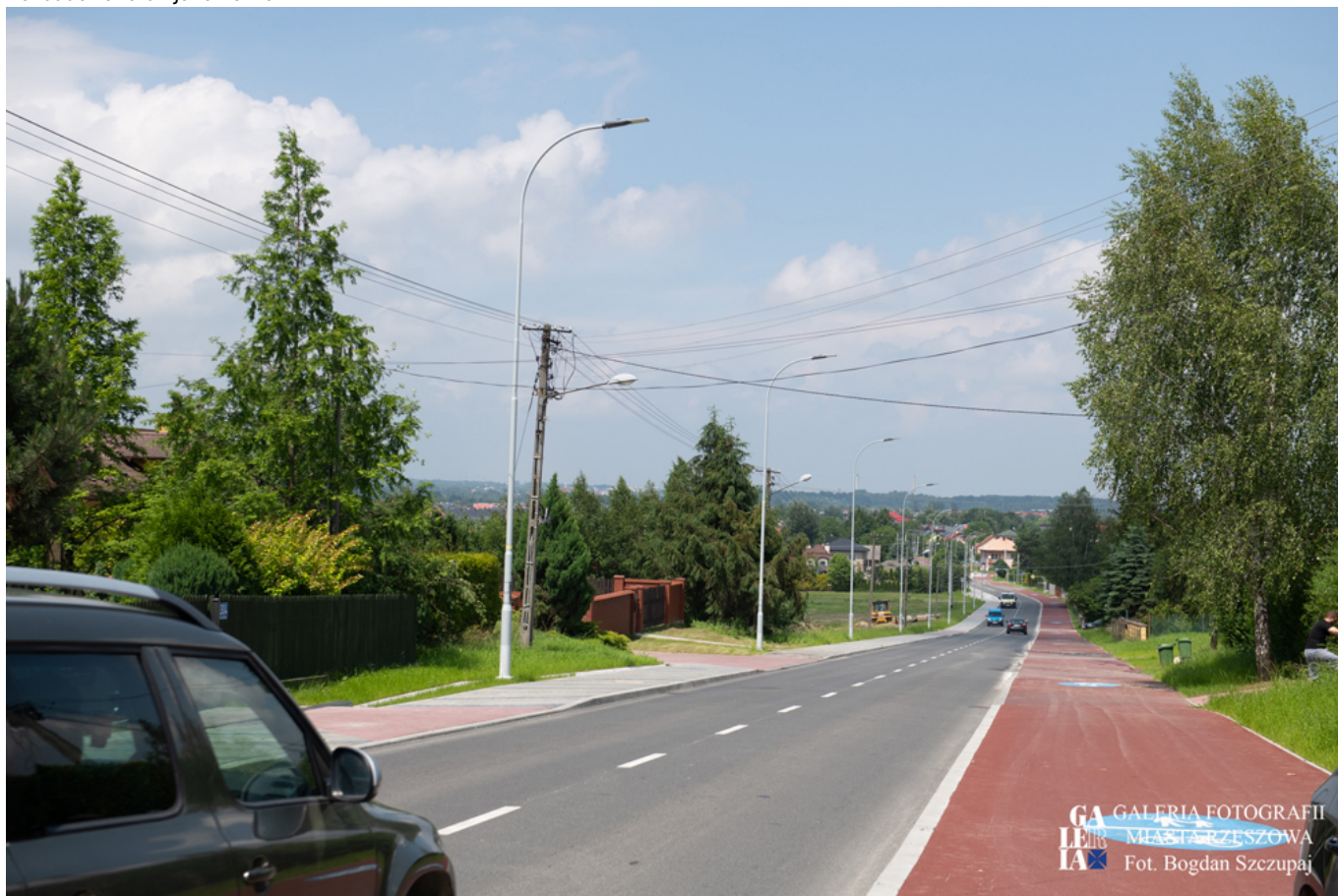
Rozbudowana ul. Jana Pawła II
