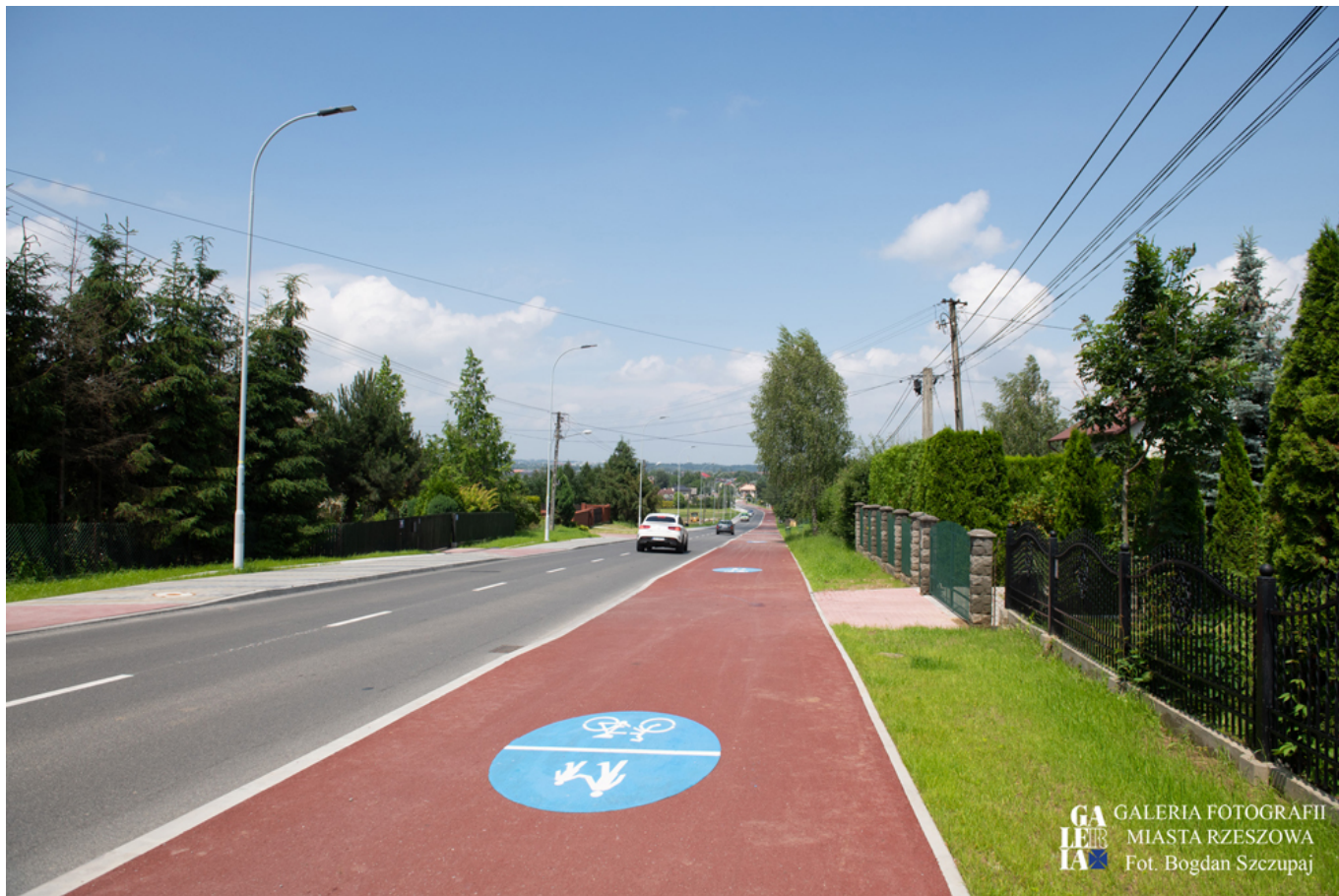
Rozbudowana ul. Jana Pawła II
