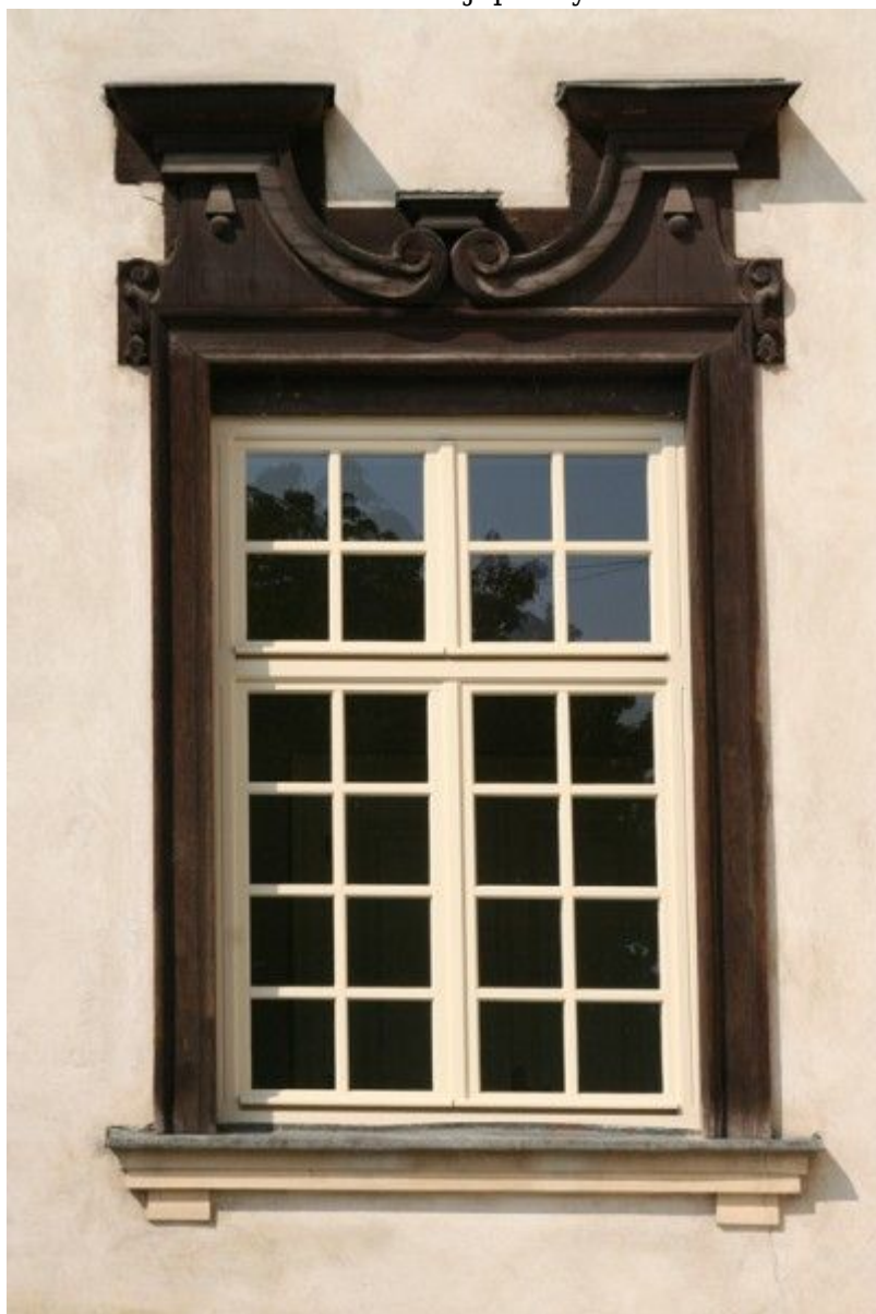
Detale architektoniczne elewacji pałacyku
