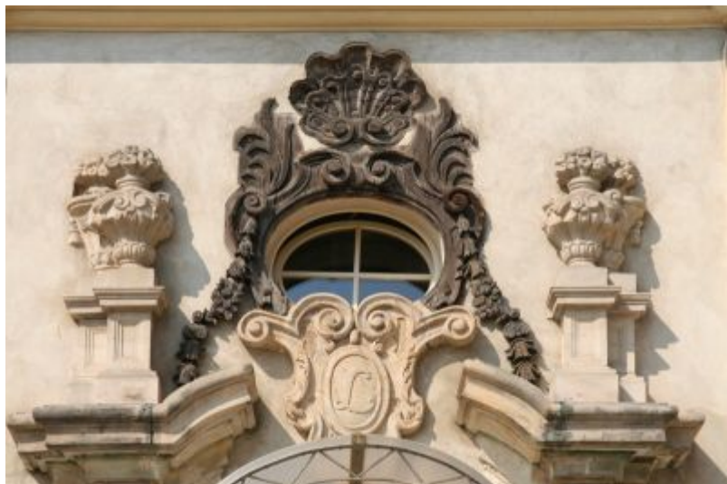
Detale architektoniczne elewacji pałacyku
