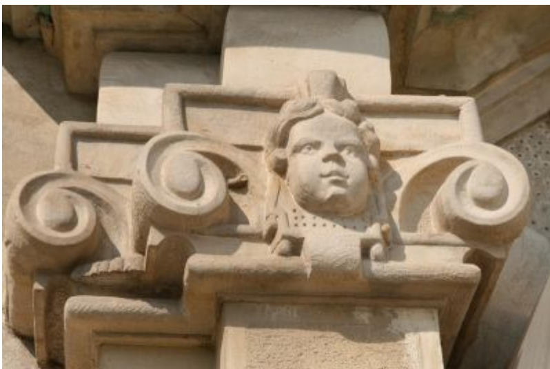
Detale architektoniczne elewacji pałacyku
