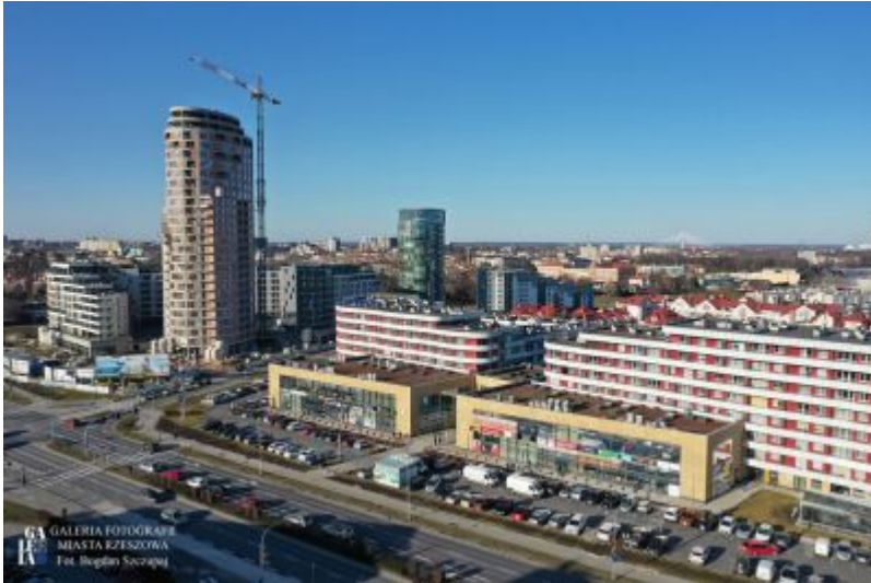
Capital Towers w budowie (2020 r.)
