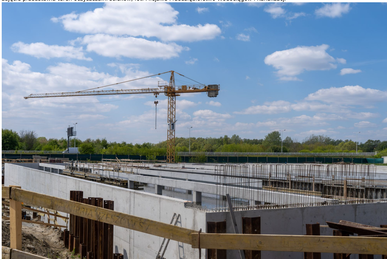
zdjęcie przedstawia teren oczyszczalni ścieków, fot. Miejskie Przedsiębiorstwo Wodociągów i Kanalizacji
