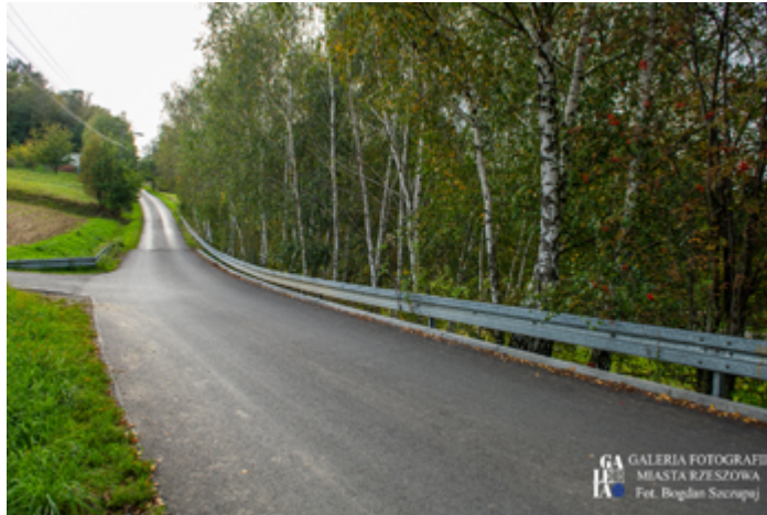
Remont ul. Nowe Wzgórze
