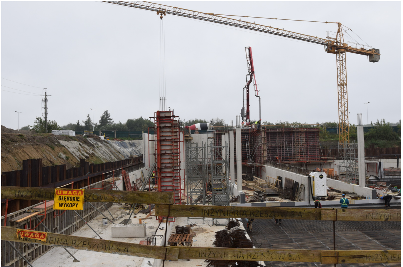
zdjęcie z terenu rozbudowy oczyszczalni ścieków w Rzeszowie, fot. MPWiK
