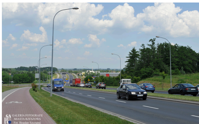
Budowa połączenia ul. Lubelskiej i Warszawskiej - koszt inwestycji: 29 mln zł
