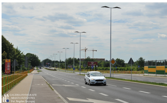
Budowa łącznika do autostrady A4
