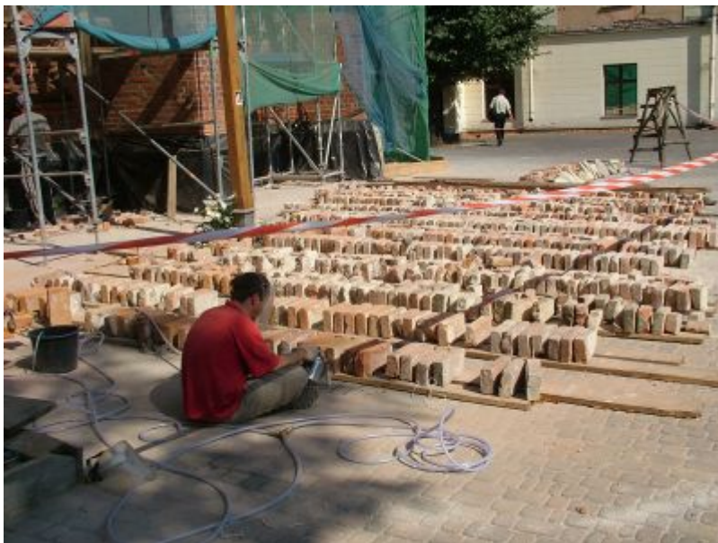
Rzeszów, kościół farny, suszenie, oczyszczanie i postarzanie cegieł porozbiórkowych, fot. M. Filip 2007 r.
