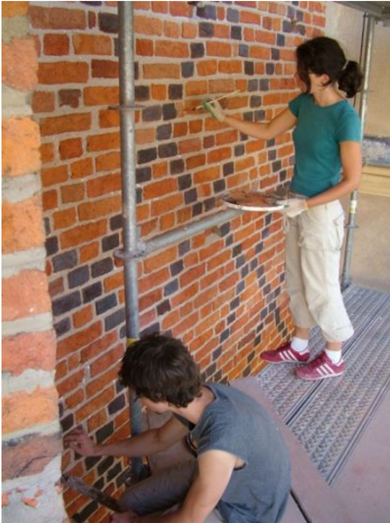
Rzeszów, kościół farny, fragment muru podczas scalania kolorystycznego kitów i rombowego wzoru, fot. M. Filip 2008 r.
