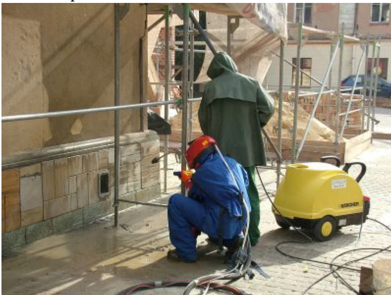
Rzeszów, kościół farny, fragment kamiennego cokołu podczas oczyszczania z brudu, fot. M. Filip 2011 r.
