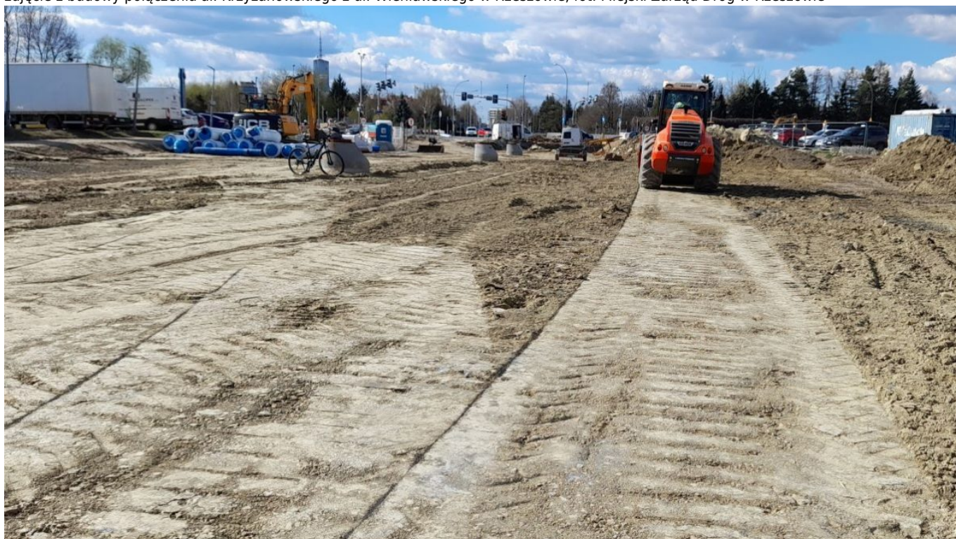
zdjęcie z budowy połączenia al. Krzyżanowskiego z ul. Wieniawskiego w Rzeszowie, fot. Miejski Zarząd Dróg w Rzeszowie
