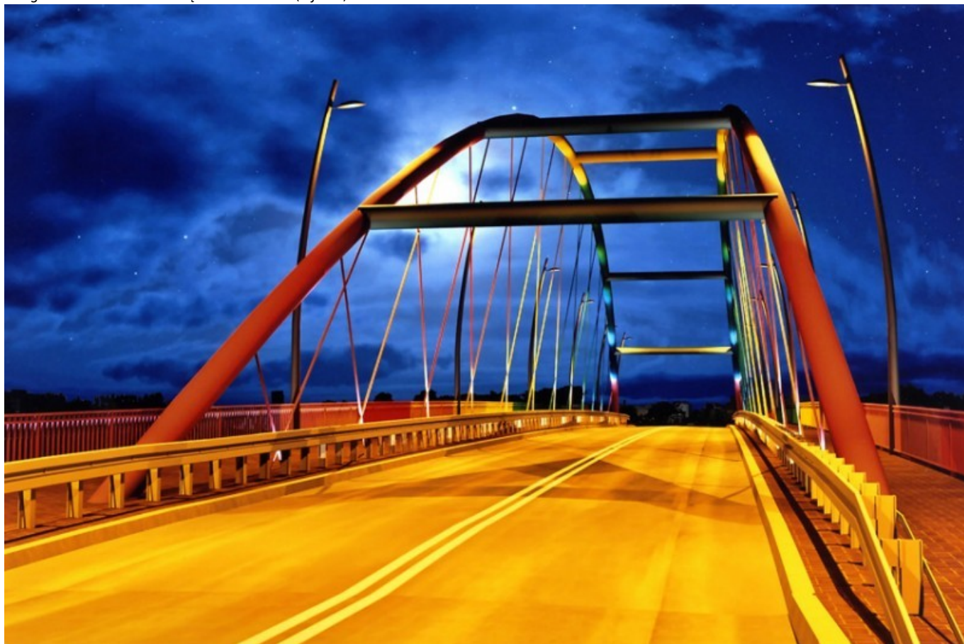
II nagroda - oświetlenie Mostu Narutowicza
