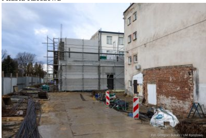
zdjęcie z terenu budowy Zespołu Szkół Elektronicznych w Rzeszowie, fot. Grzegorz Bukała, Urząd Miasta Rzeszowa
