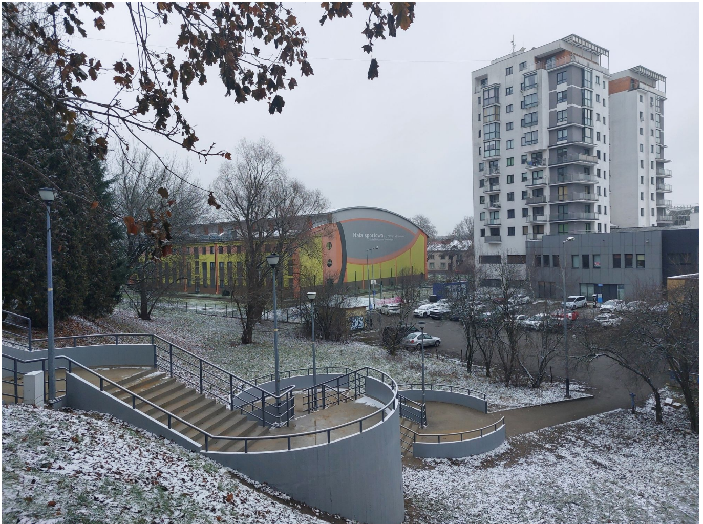
zdjęcie schodów przy ul. Hetmańskiej
