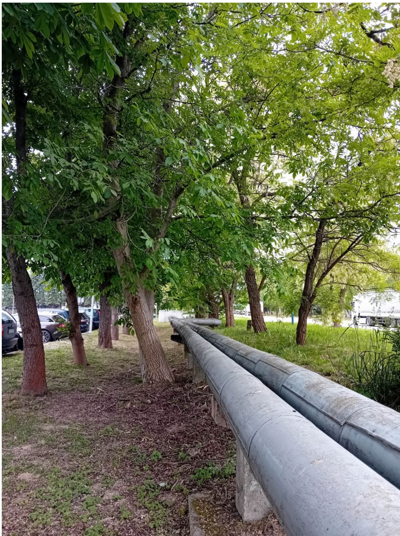
zdjęcie z przebudowy nadziemnej sieci ciepłowniczej przy ulicy Przemysłowej, fot. Miejskie Przedsiębiorstwo Energetyki Ciepłej
