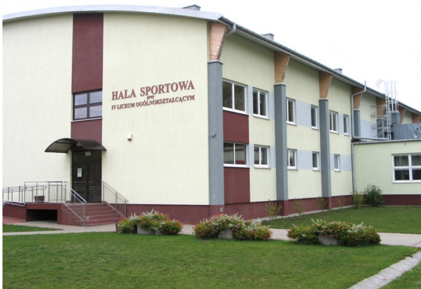
Nowa hala sportowa przy IV Liceum Ogólnokształcącym
