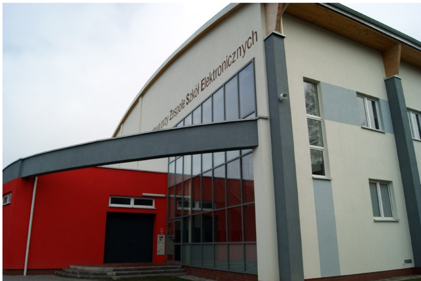
Nowa hala sportowa przy Zespole Szkół Elektronicznych
