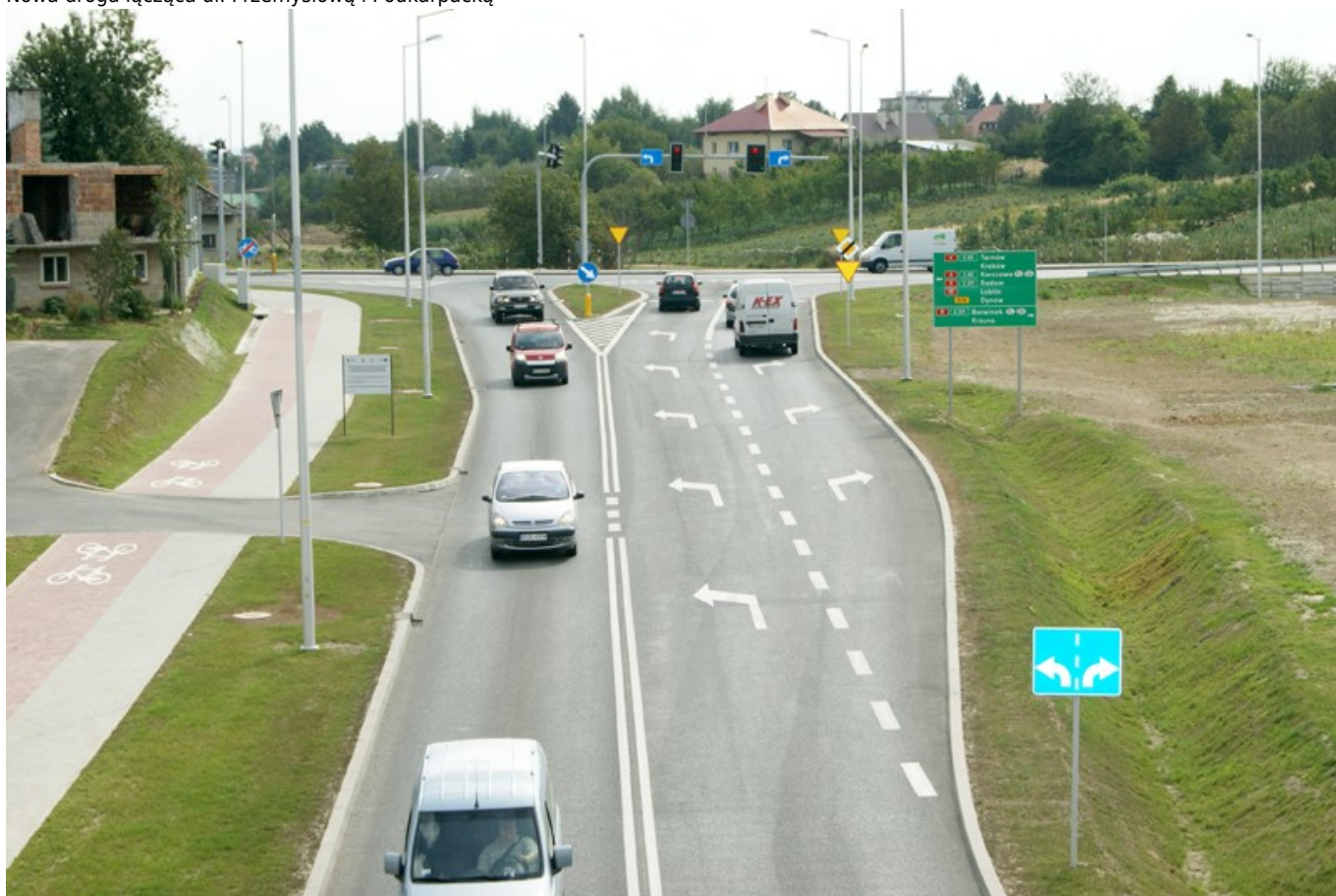
Nowa droga łącząca ul. Przemysłową i Podkarpacką
