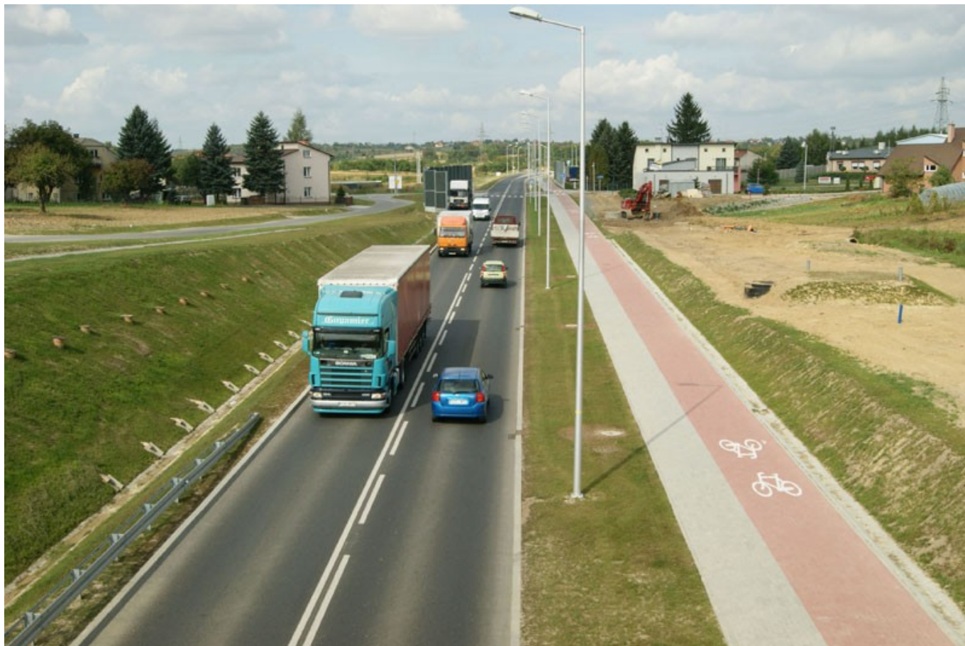
Nowa droga łącząca ul. Przemysłową i Podkarpacką
