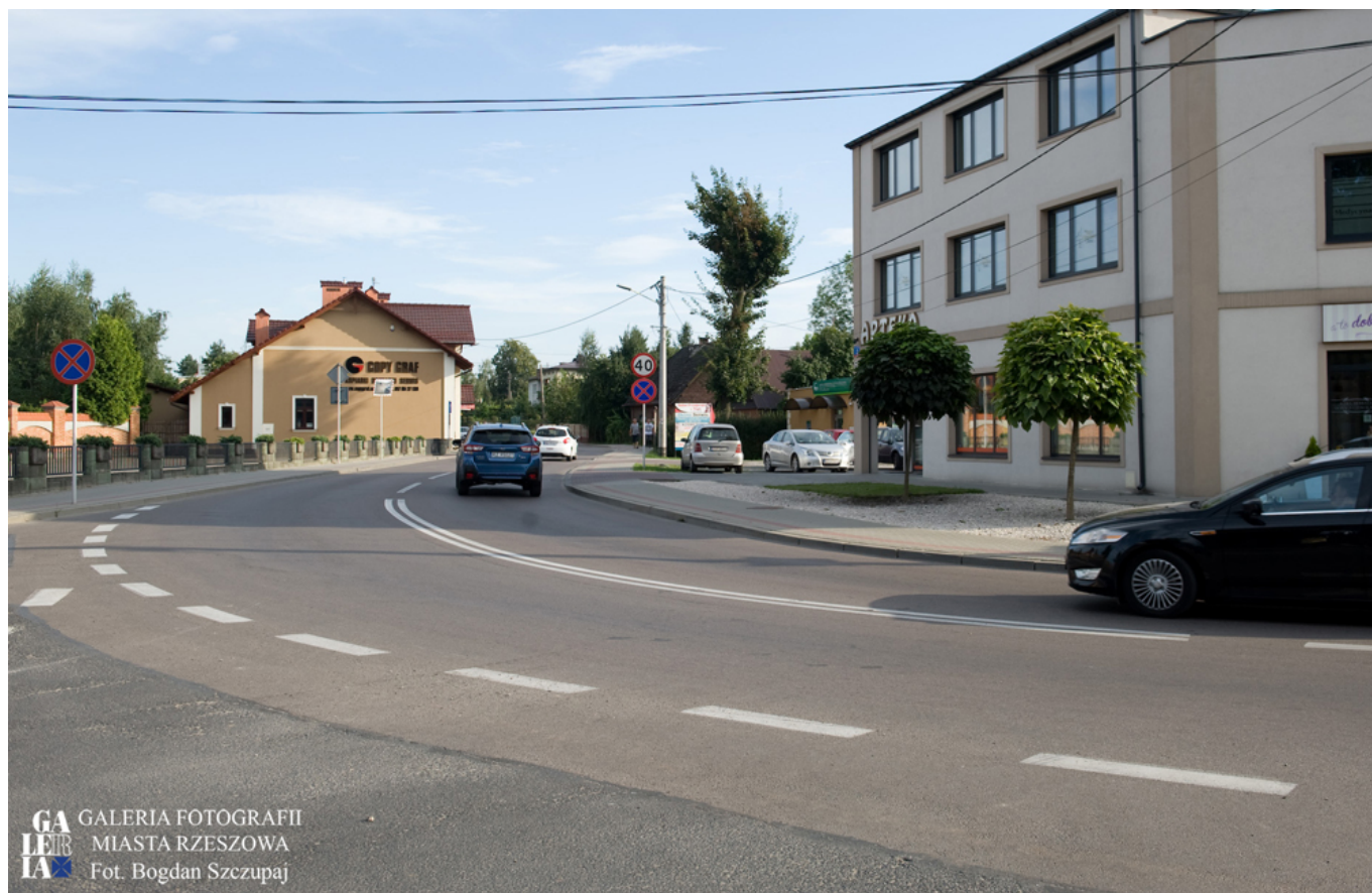
Przebudowana ulica Paderewskiego
