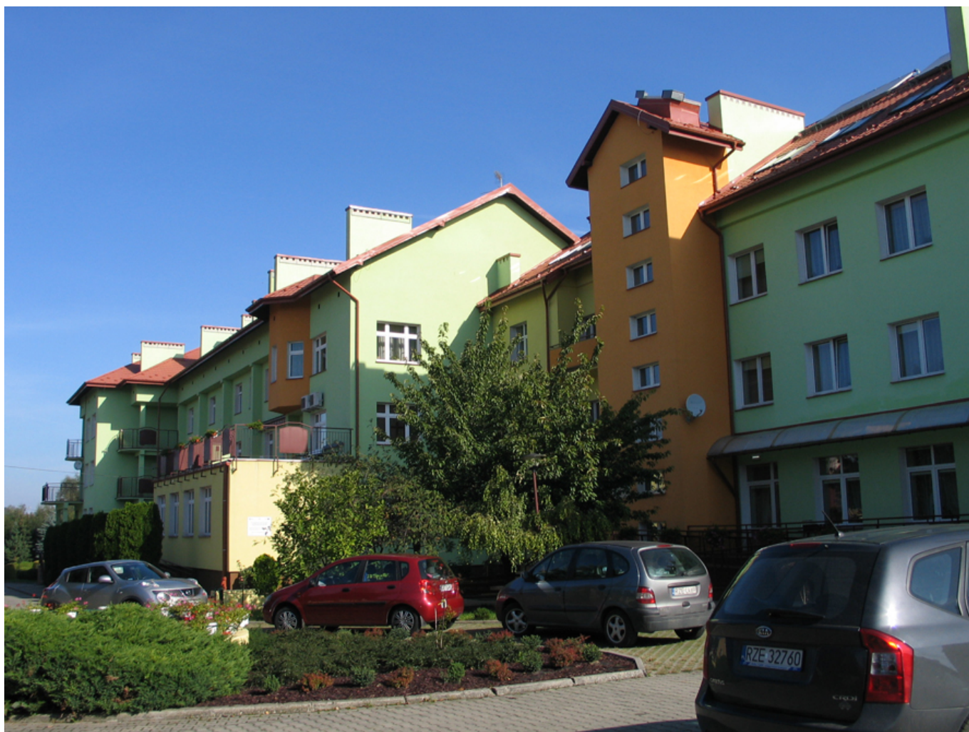
Budynek DPS przy ul. Powstańców Styczniowych
