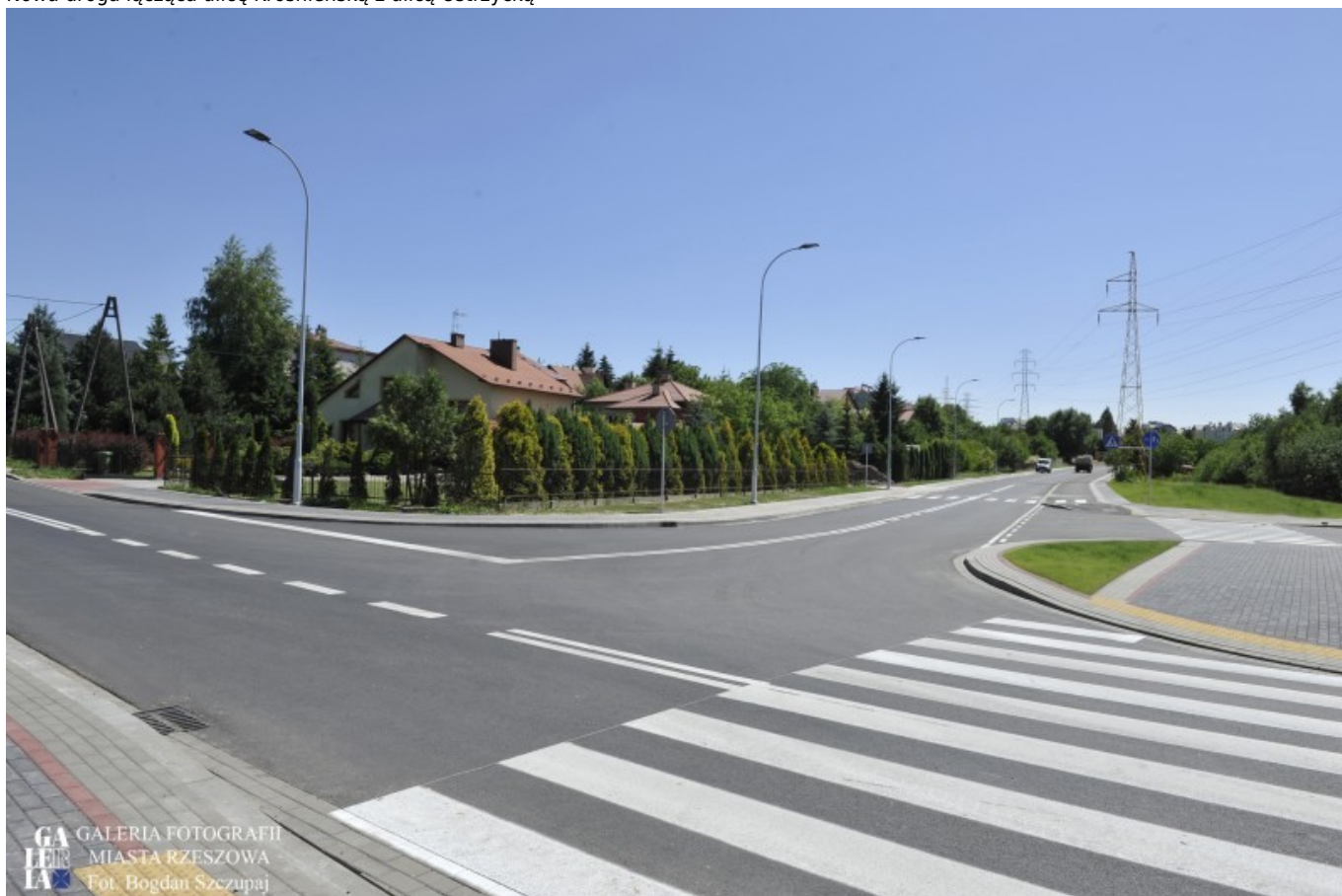
Nowa droga łącząca ulicę Krośnieńską z ulicą Ustrzycką
