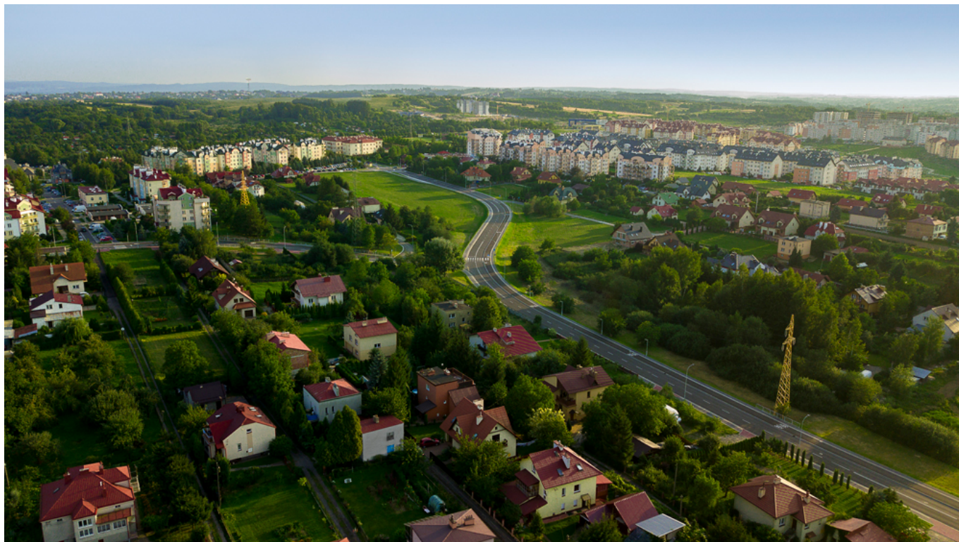
Nowa droga łącząca ulicę Krośnieńską z ulicą Ustrzycką
