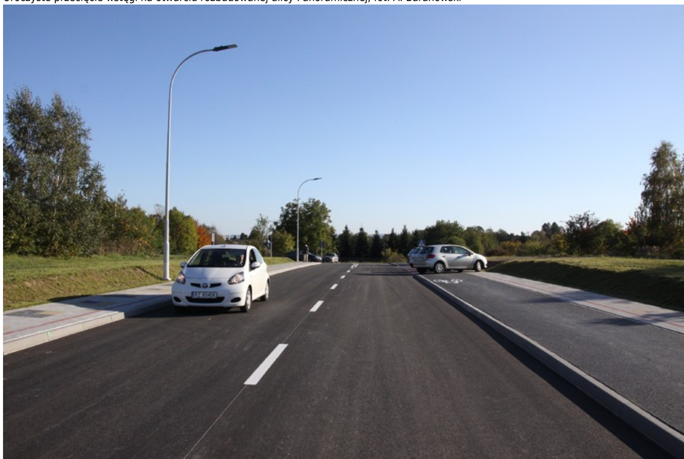
Rozbudowana ulica Panoramiczna, fot. A. Baranowski
