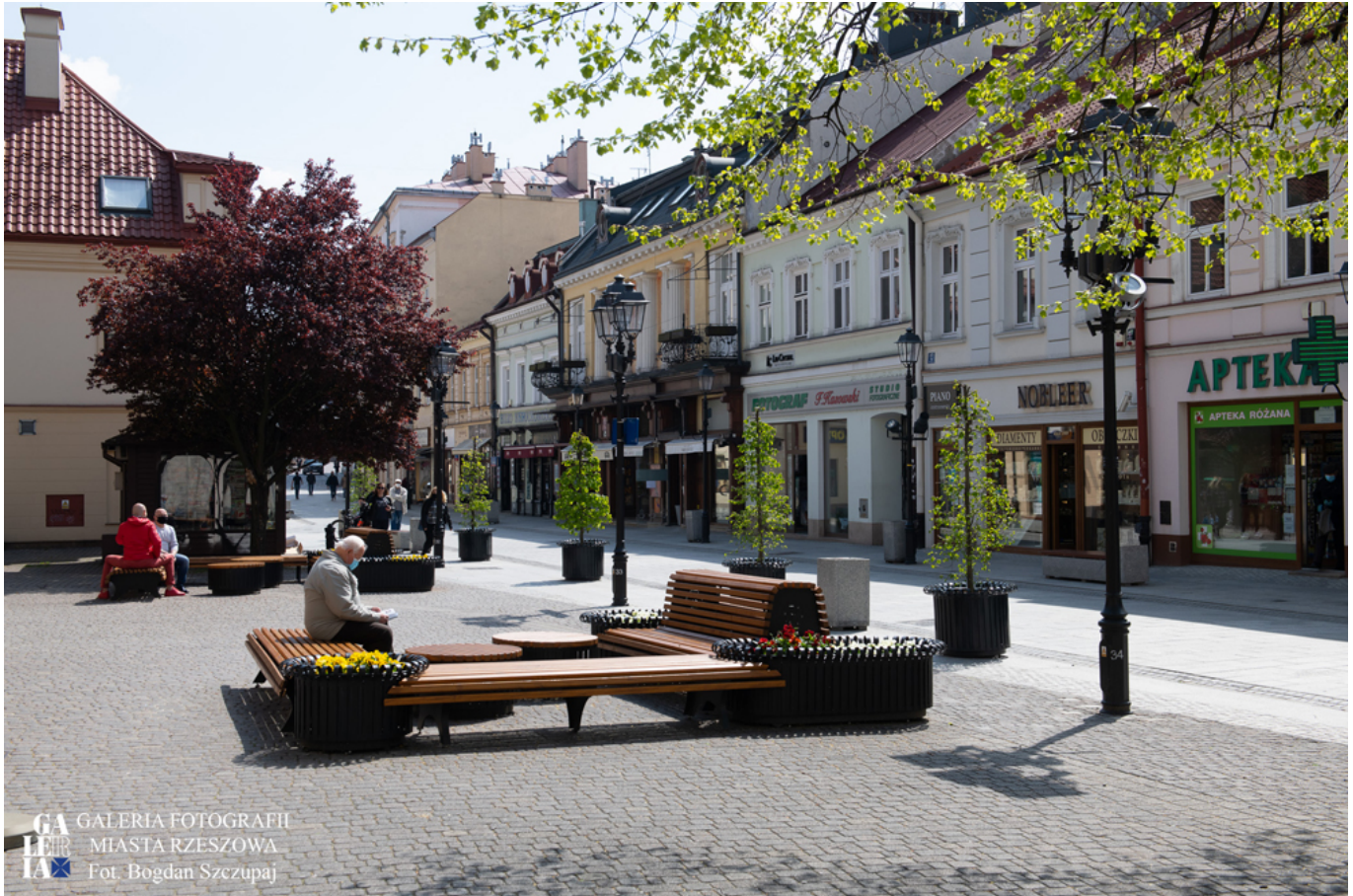
Przebudowana ul. Kościuszki (2020 r.)
